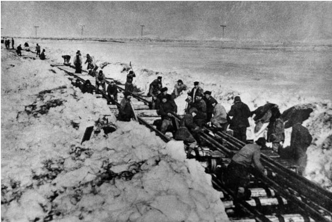
Construction de la voie ferrée : la ligne Salekhard-Igarka - 1948 (© Tomasz Kizny)
